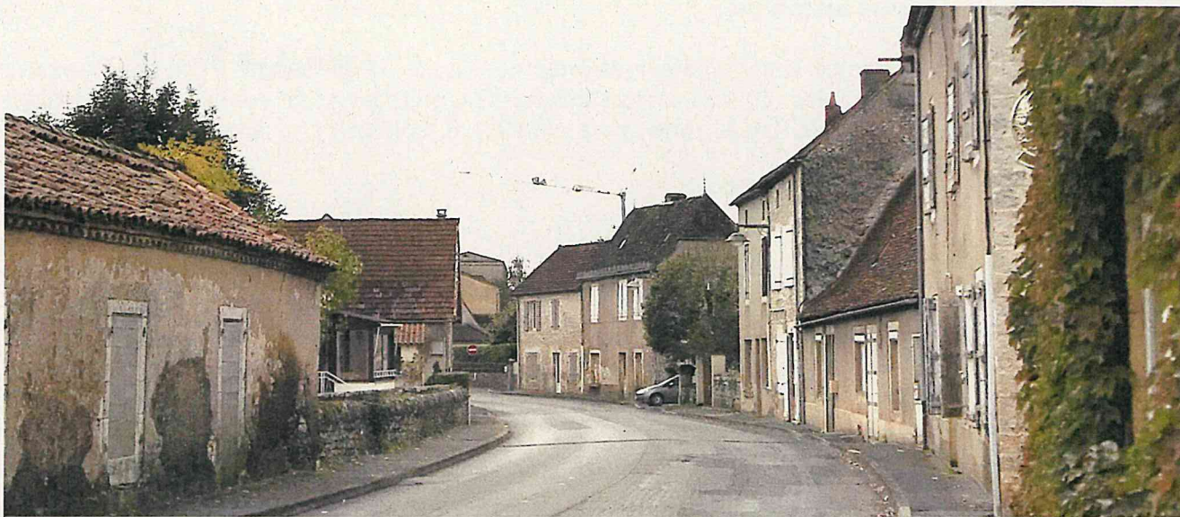
Avenue Louis Conte, limite nord-ouest du faubourg. Photo UDAP46
